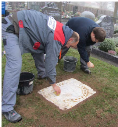
Steinmetz Paffrath beim Verlegen
