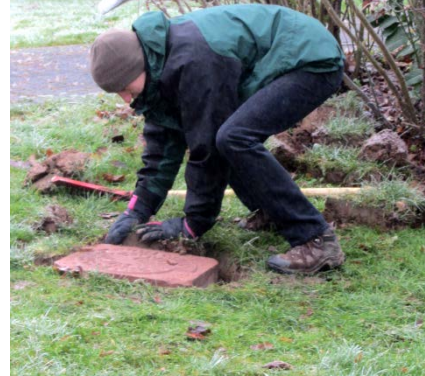
Martin Blöcher (HKB) beim Verlegen
